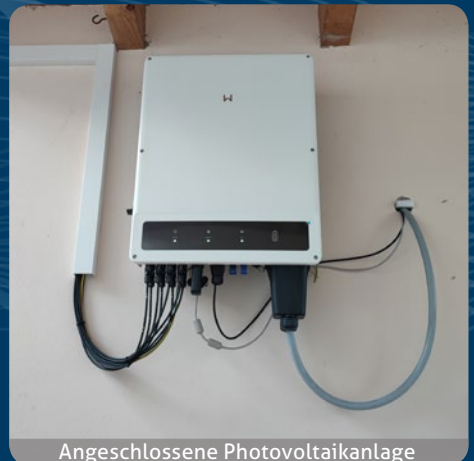
Angeschlossene Photovoltaikanlage
