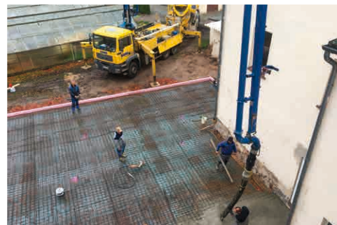
Die Bodenplatte wird gegossen
